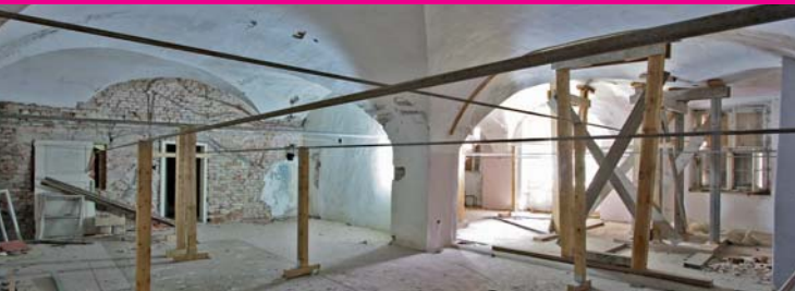
SCHLOSS QUILOW, ERDGESCHOSS, TONNENGEWÖLBTE HALLE
